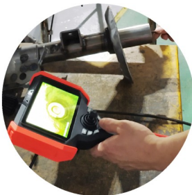
焊接管内部检查
