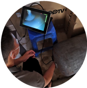
缸体焊接点检测
